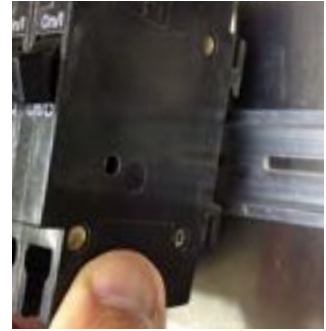
4) Snap the Breaker onto the DIN Rail.
